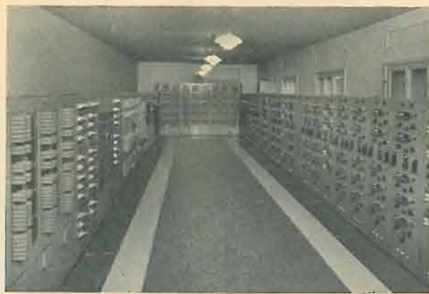
Sala degli amplificatori del nuovo impianto di Radio Torino.
